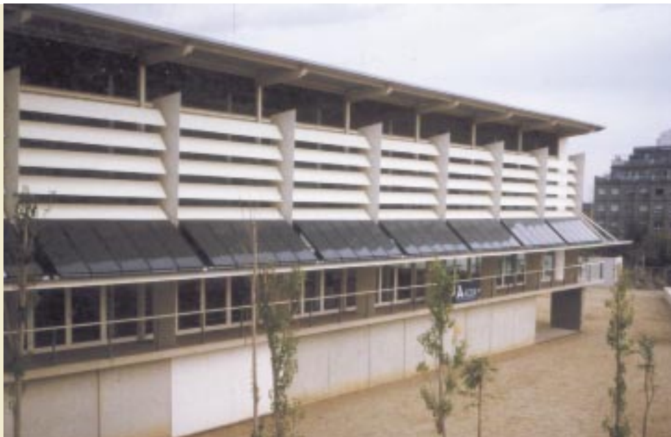
Vista exterior del Polisportiu Guinardó
